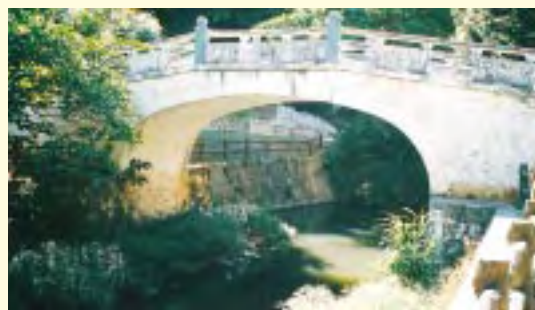
牧港川上流千支橋付近
