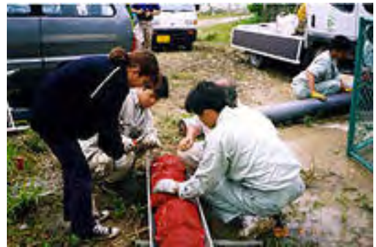
上流側の取り付け、塩ビの管に木炭を詰めて いる様子です。
