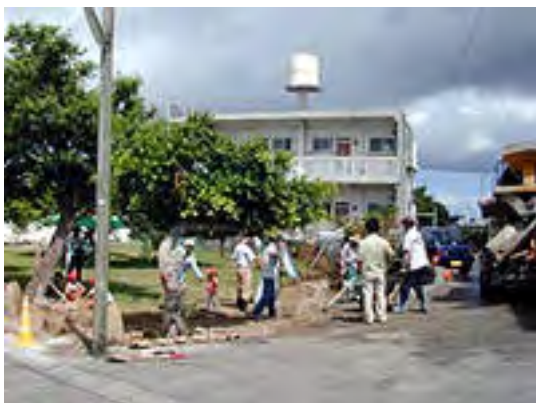
まず、入り口の土間コンクリート打ちで
