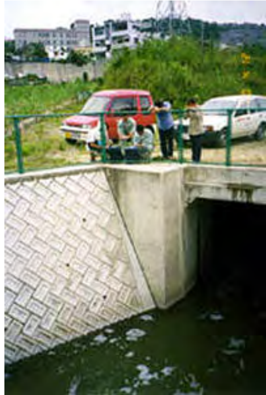
3面張りの上流川です。
