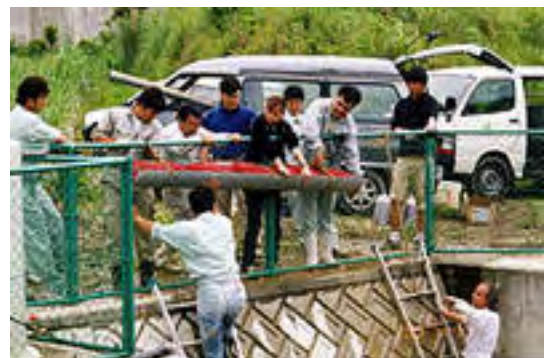
さていよいよ設置。
