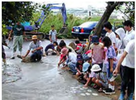
土間コンクリートが乾く前にタイルを張り込みます。
